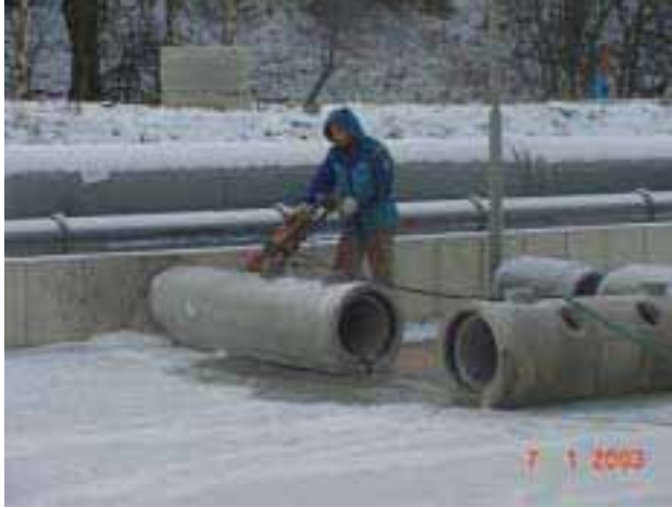
Bild 2: Bohrvorgang
