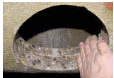
Bild 6: Kontrolle der Bohrlochwandung
