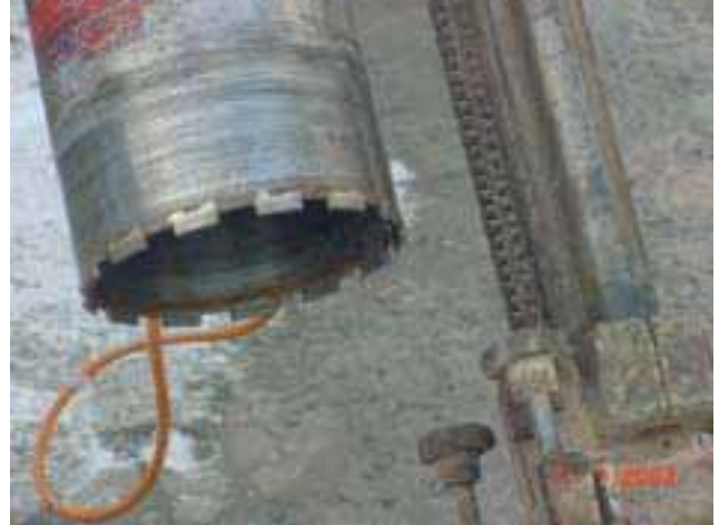
Bild 3: Ansicht der Bohrkronen
