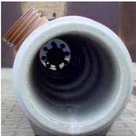
Bild 20: Kettenschleuder im Rohr
