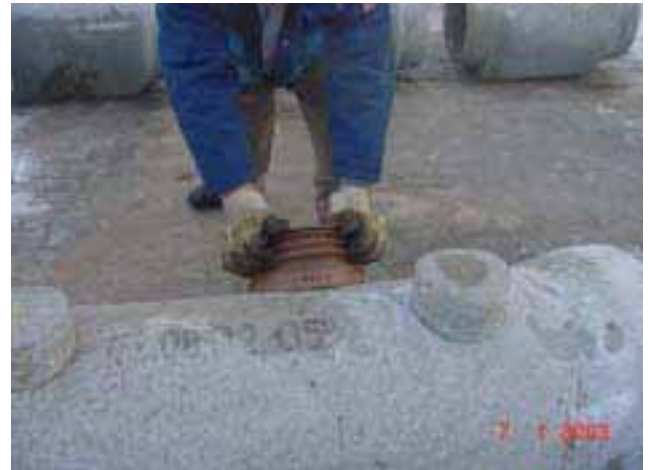
Bild 10: Einschieben des Stutzens in das Bohrloch
