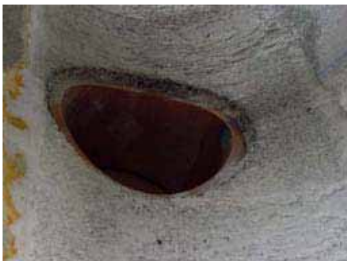
Bild 29: Betonrohr mit Stutzen nach Schwefelsäurebefüllung
