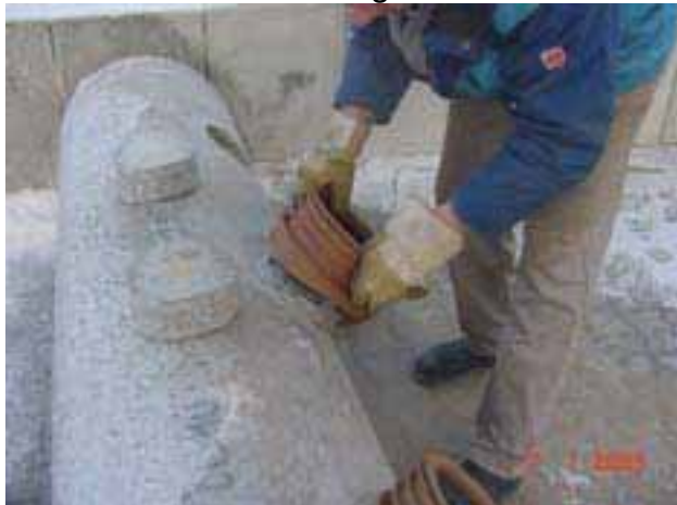
Bild 7: Auftragen des Gleitmittels auf die Bohrlochwandung
