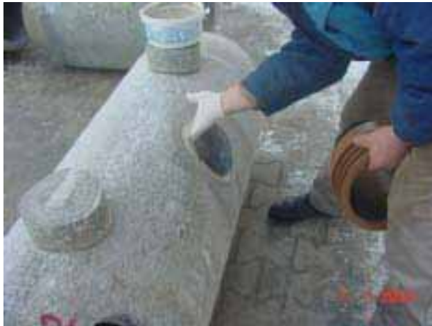
Bild 7: Auftragen des Gleitmittels auf die Bohrlochwandung
