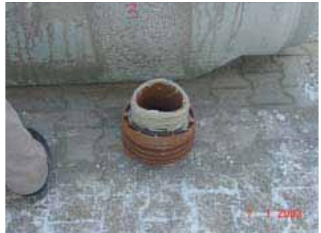
Bild 8: Gleitmittel auf dem Stutzenunterteil
